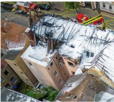
Löschschaum liegt auf dem Dach des Hauses.
