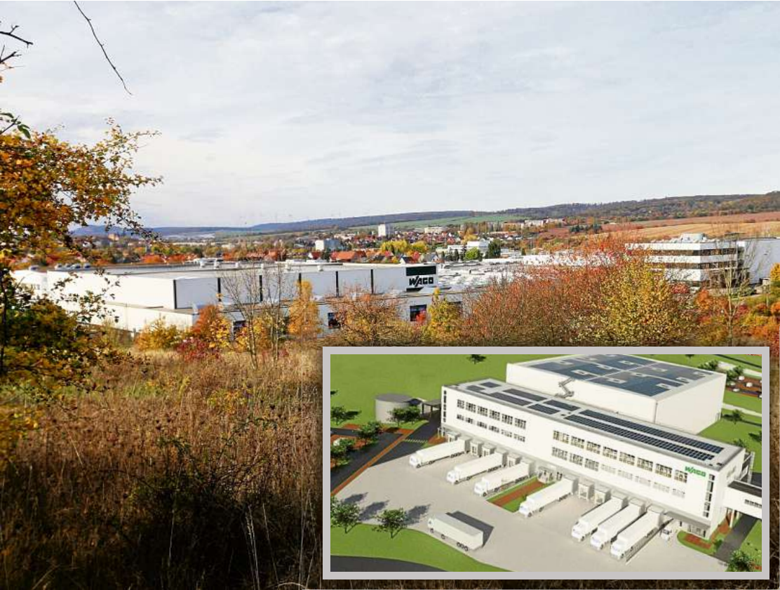
Auf einer 35.000 Quadratmeter großen Brachfläche neben dem Wago-Werk in Sondershausen soll das neue Logistikzentrum der Firma entstehen.
