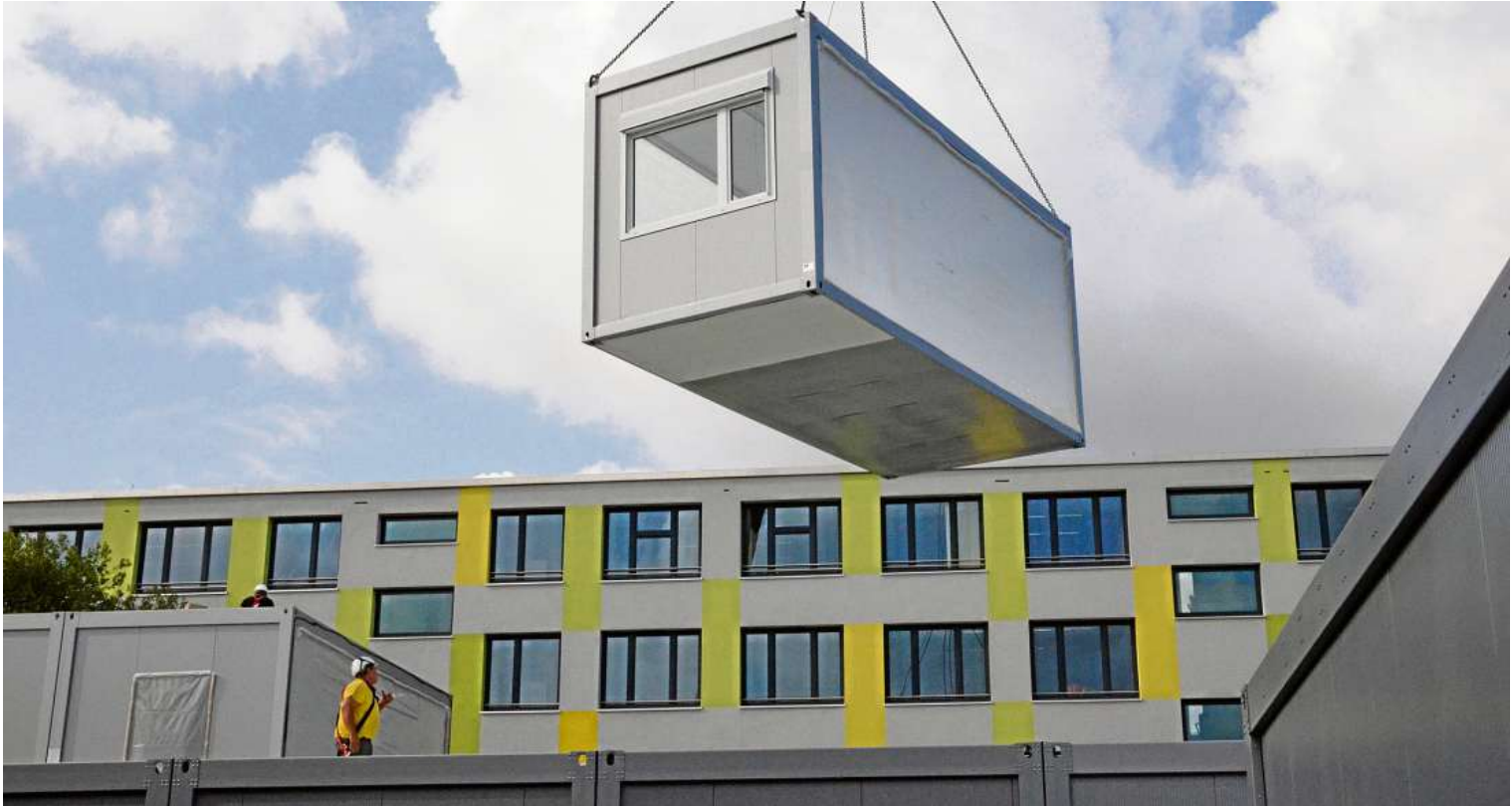
Am Erfurter Hannah-Arendt-Gymnasium wird eine Containerschule aufgebaut.
