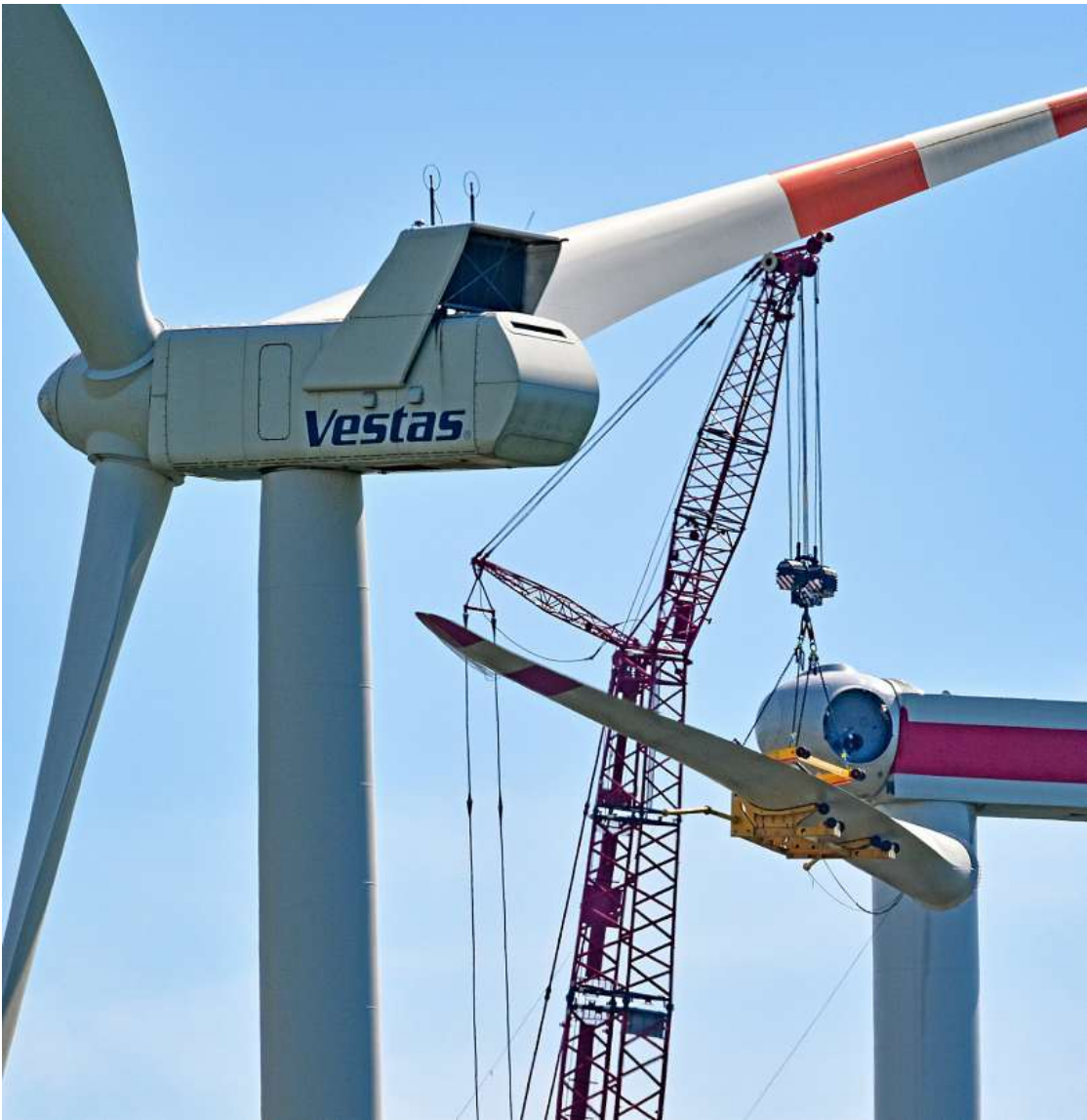
Ein Rotorblatt wird an einer neuen Windkraftanlage montiert.
