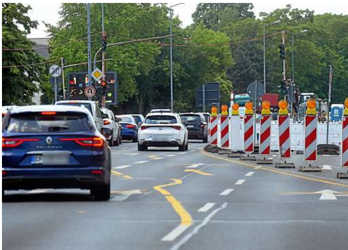
Noch geht es in Schlangenlinie weiter. Ab kommender Woche ist der Juri-Gagarin-Ring hier dicht.
