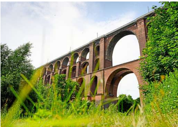
Die Göltzschtalbrücke im Vogtland: Bis zur Fertigstellung im Jahr 1851 wurden 26 Millionen Ziegel verbaut. ROBERT MICHAEL/PA/DPA
